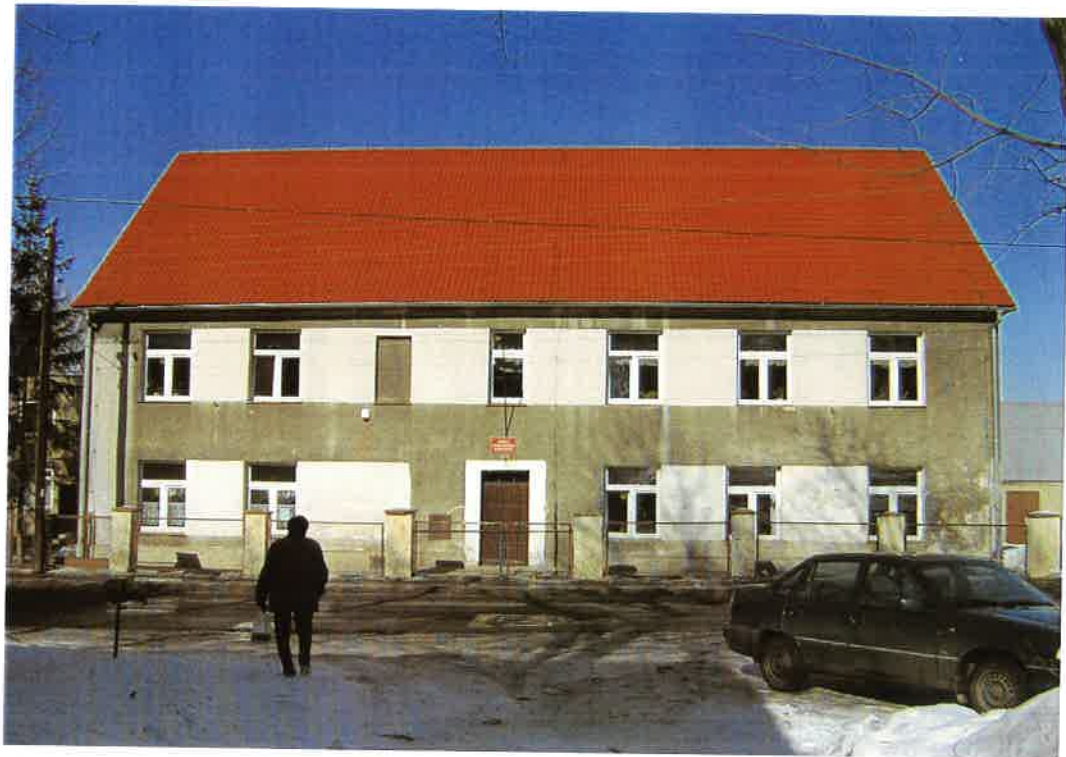
1. Budynek A – elewacja południowa
