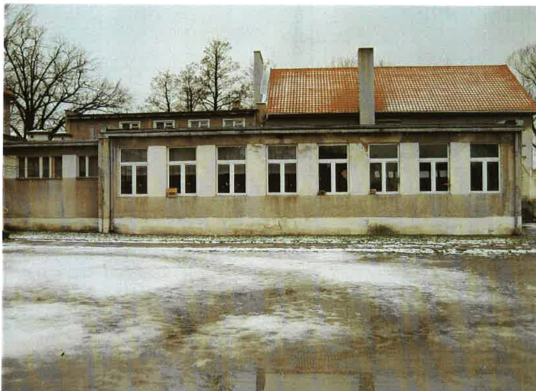
3. Budynek B – elewacja wschodnia
