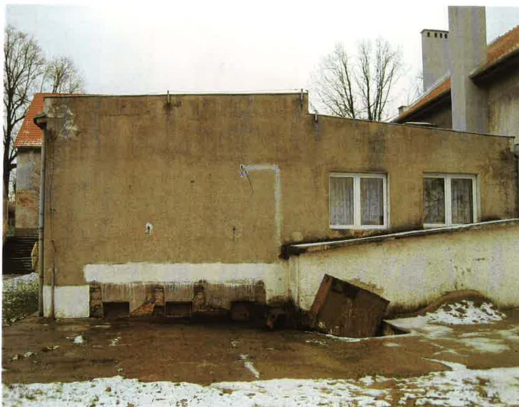
4. Budynek B – elewacja północna
