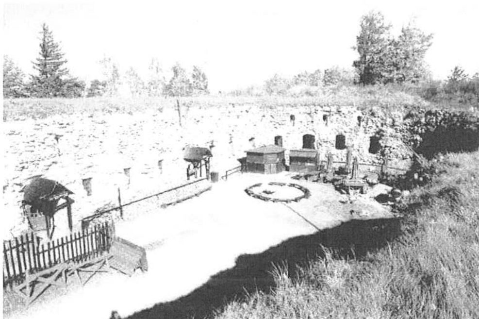
fot. 1: Bastion Dolny, dziedziniec, widok od południa
