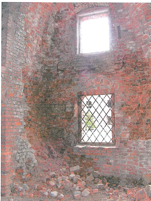
Ściana z otworami okiennymi
