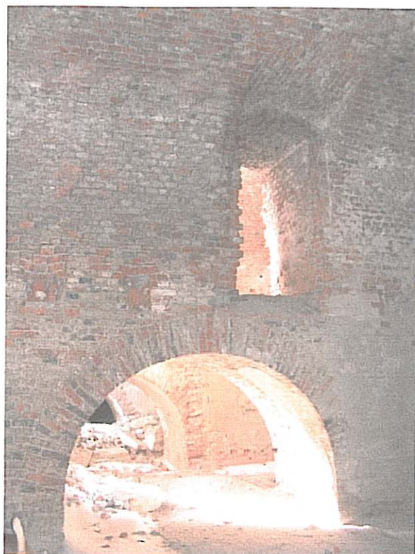
Wnętrze kazamat kieszeni
