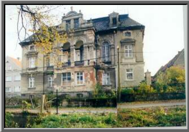
fotografia nr 2525. Zdewastowany budynek mieszkalny stanowiący obiekt większego zespołu dworskiego – Stoszewice
