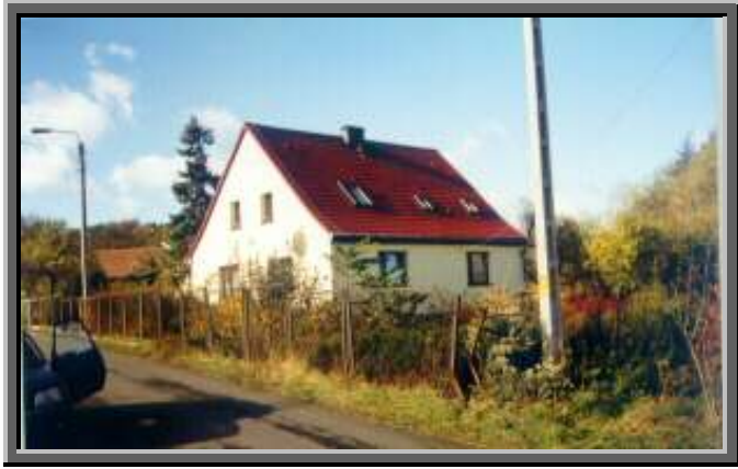
fotografia nr 2626. Wyremontowany i zmodernizowany budynek mieszkalny - Mikołajów
