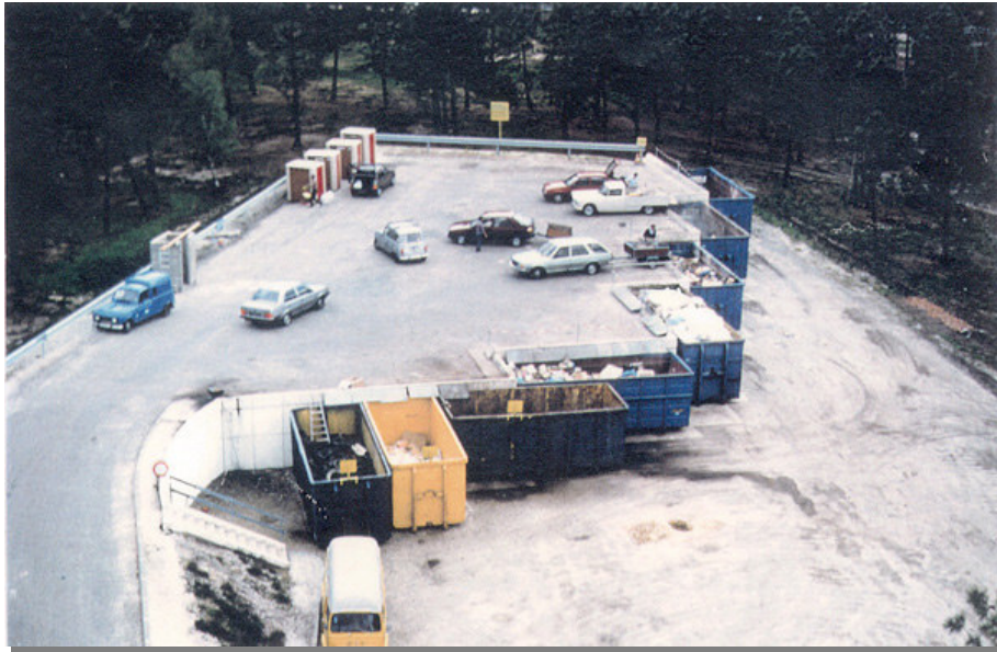
Rys. 10 Rampa wyładowcza dla wielu pojazdów
